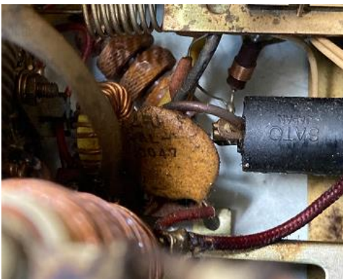
PT パスコンかなり変えづらいところにあります。
